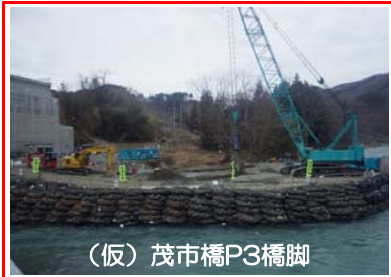
(仮)茂市橋P3橋脚では、締切鋼矢板の打設を行っています。
