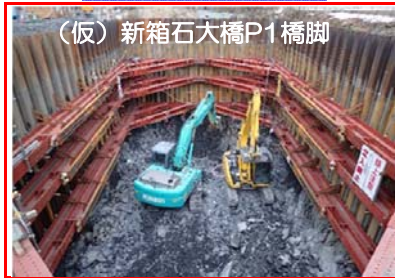
(仮)新箱石大橋P1橋脚の掘削作業を行っています。
