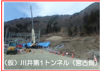
(仮)川井第1トンネル（宮古側）でトンネル工事のためのバッチャープラントを組み立てています。
