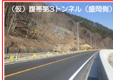
(仮)腹帯第3トンネル（盛岡側）は落石防護網が完了し、法面工の施工を進めています。
