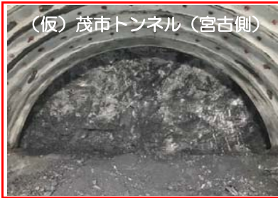
(仮)茂市トンネルの掘削を行っています。全長1,885mのうち116mまで進んでいます。
