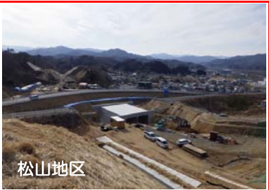
松山地区で、函渠工の施工を行っています。
