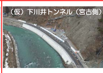
古田地区の国道切り回し作業が完了しました。引き続き坑口部の落石防止対策工事を行っています。
