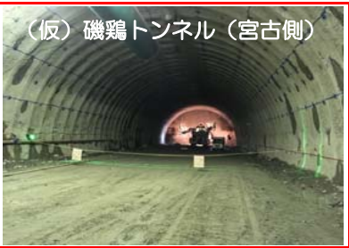
(仮)磯鶏トンネルの掘削を行っています。全長1,554m（844mは大成建設で施工）のうち163mまで進んでいます。
